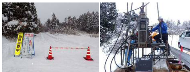
【ボーリング調査状況】
