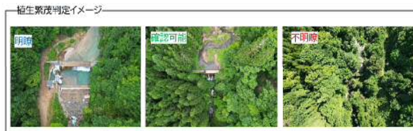
▲ ②UAVによる空撮
