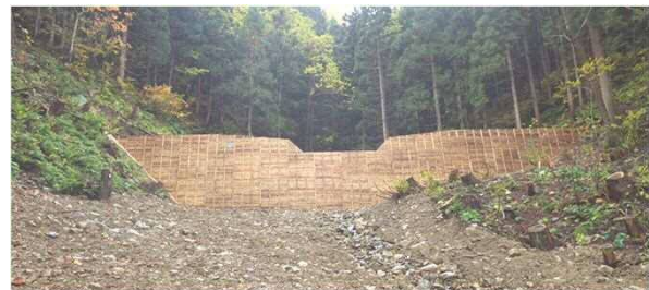
No.10 谷止工(完成後)
