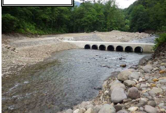
2号洗越工（上流から）
