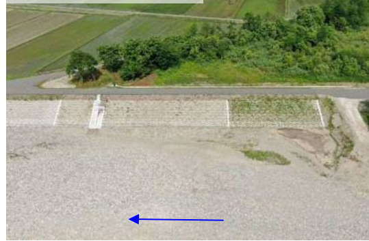
完成[対岸から撮影]
