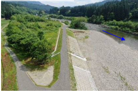
完成[下流から撮影]
