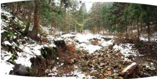
No.10 谷止工(着手前)
