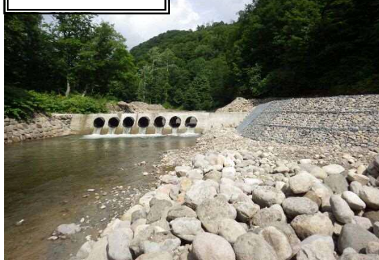
2号洗越工（下流から）
