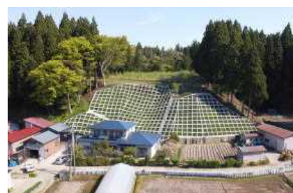
直下の人家を保護する法枠工
