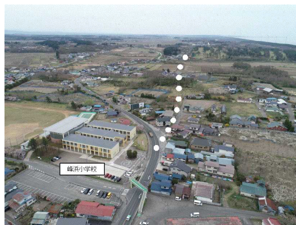
国道101号（峰浜水沢工区）
