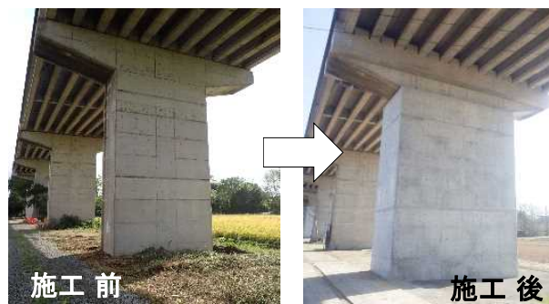
能代高架橋（耐震補強）
