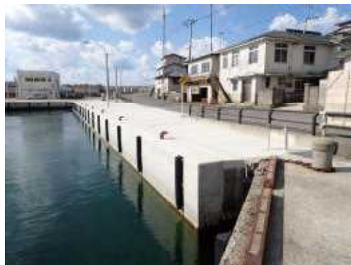
㊴－3.0m第2岸壁の補修（岩館漁港）
