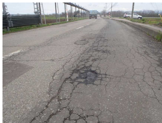
舗装補修予定箇所
