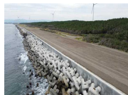
飛砂防備保安林を保全する防潮工
