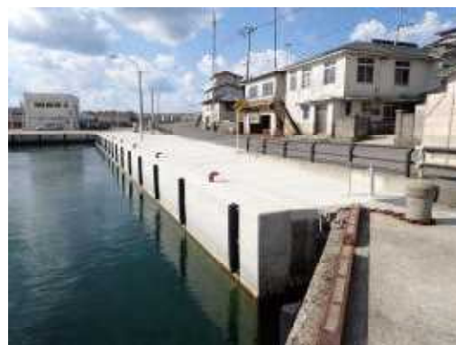
㊹－3.0m第2岸壁の補修（岩館漁港）
