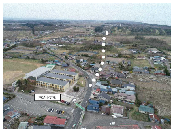
国道101号（峰浜水沢工区）
