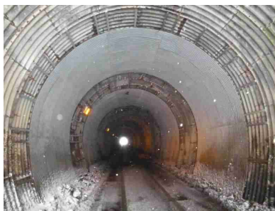
トンネル全体
