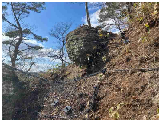
きみまち阪公園素波里湖線（落石対策状況）
