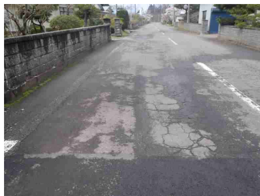
舗装補修予定箇所
