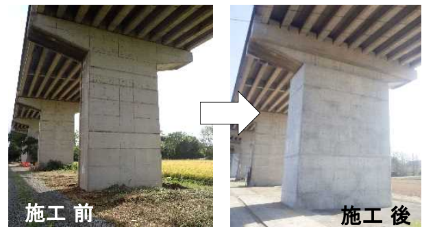
能代高架橋（耐震補強）
