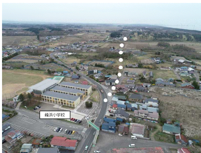
国道101号（峰浜水沢工区）
