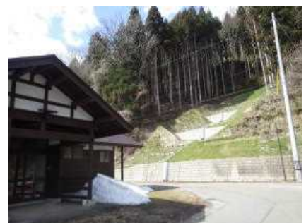
人家を保護する山腹工
