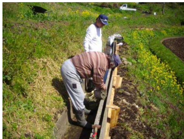
＜図＞農村環境保全活動（農業用水路の補修）
