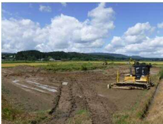
＜図＞荒廃農地の抜根・集積作業（横手市）
