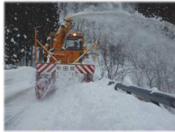
冬の安全な交通を確保する道路除雪作業
