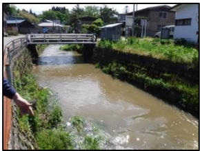
馬踏川(堀内橋)
