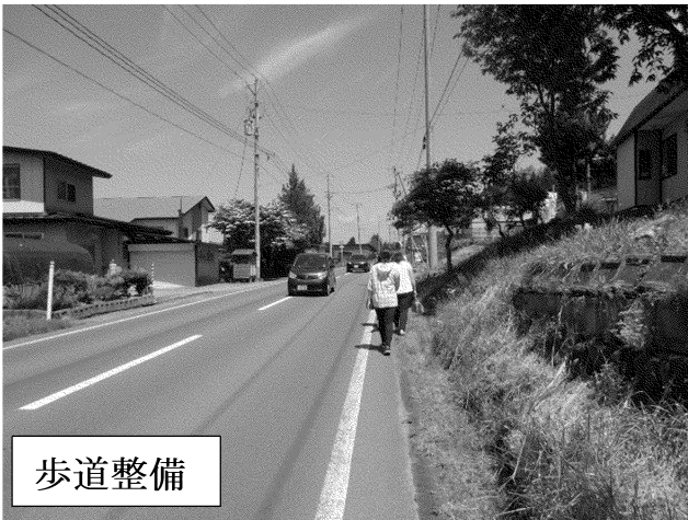
国道282号 西町工区 (鹿角市)
