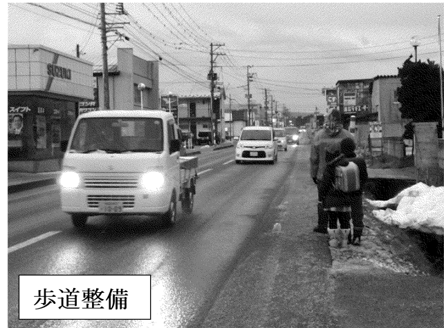
国道108号 薬師堂工区 (由利本荘市)
