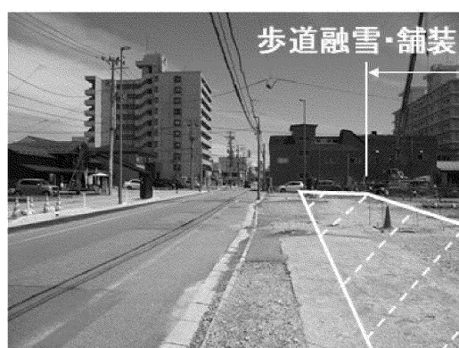
川尻広面線 横町工区 (秋田市)
