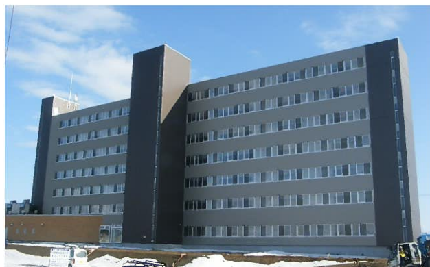
大曲駅前第二地区 都市再生住宅
