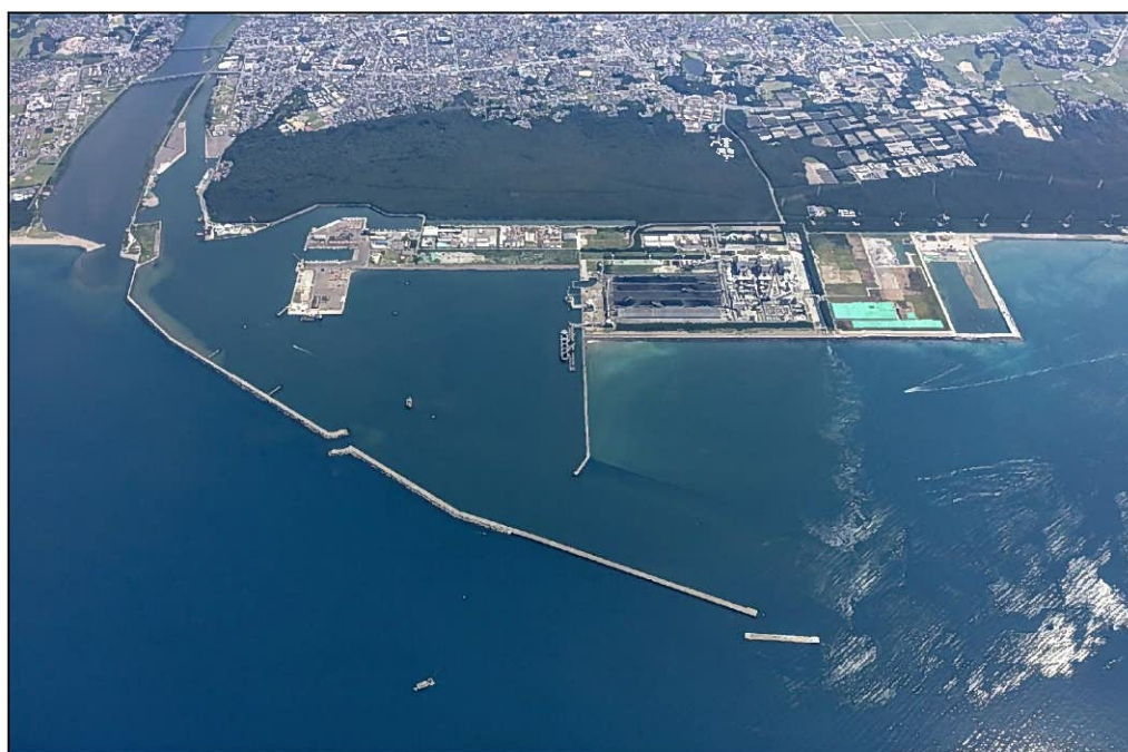
能代港全景(令和2年8月撮影)
