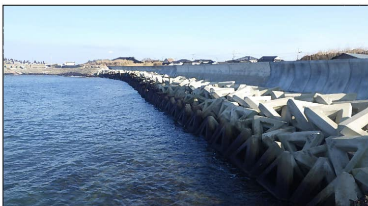
《老朽化した護岸の補修工事による機能回復》 (仁賀保海岸(芹田地区) にかほ市)
