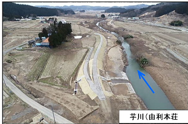
芋川(由利本荘) ≪徳沢地区築堤工事(排水樋管・堤防完了)≫
