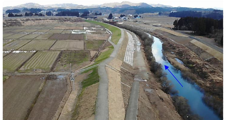
復旧工事完了
