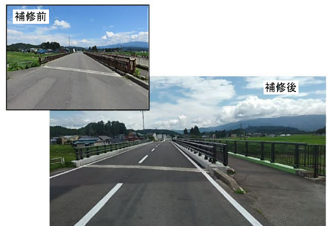
橋梁補修工((主)本荘西仙北角館線 入見内橋)
