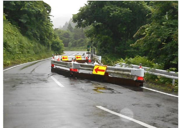
応急処理工((主)雄和岩城線)
