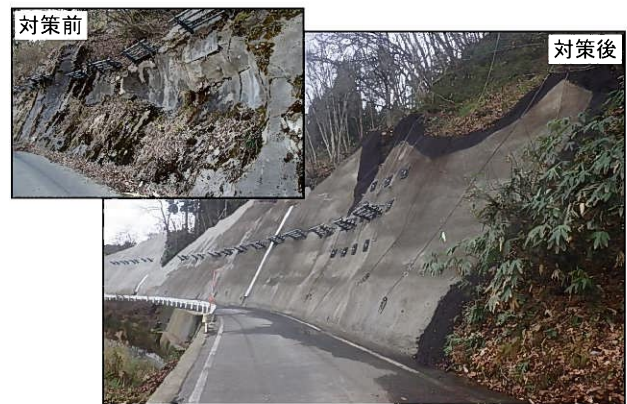
法面保護工((一)小滝二ツ井線)
