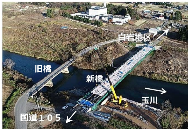
(一) 白岩角館線 仙北市 大威徳橋
