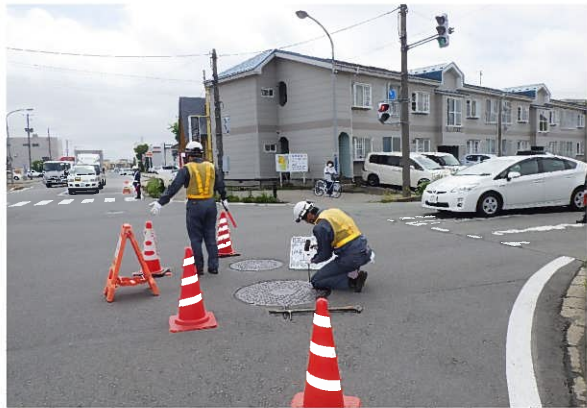
マンホールの点検
