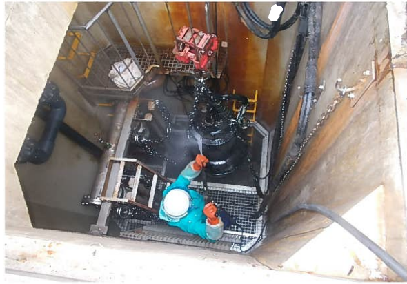
処理施設の点検
