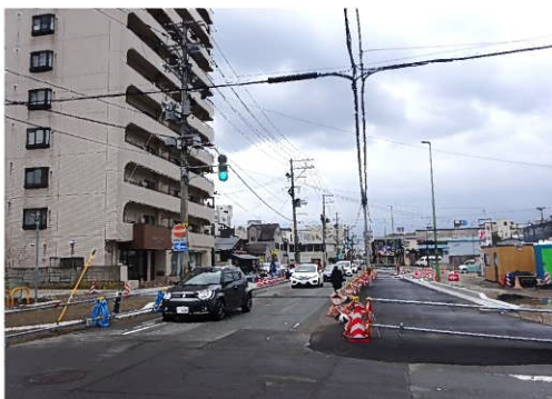
3・4・14川尻広面線 秋田市大町地内 (工事進捗状況)
