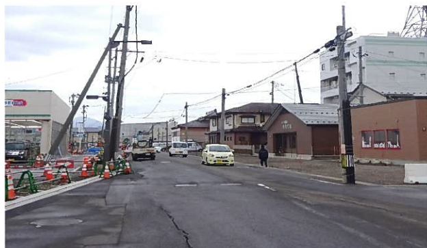
3・4・4停車場栄町線 由利本荘市裏尾崎町地内 (工事進捗状況)
