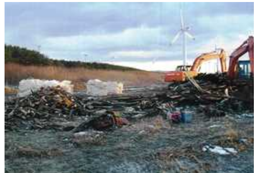
行政による木造船の解体・回収
