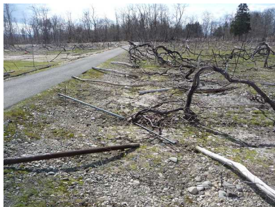
ぶどう樹及び棚の倒壊
