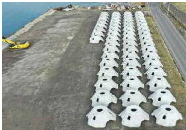
〔増殖ブロック製作状況 金浦漁場〕
