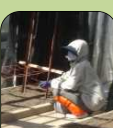
フラワーネット張り
