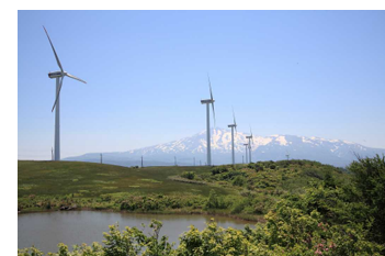
仁賀保高原の風力発電(にかほ市)
