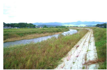
護岸整備された河川
