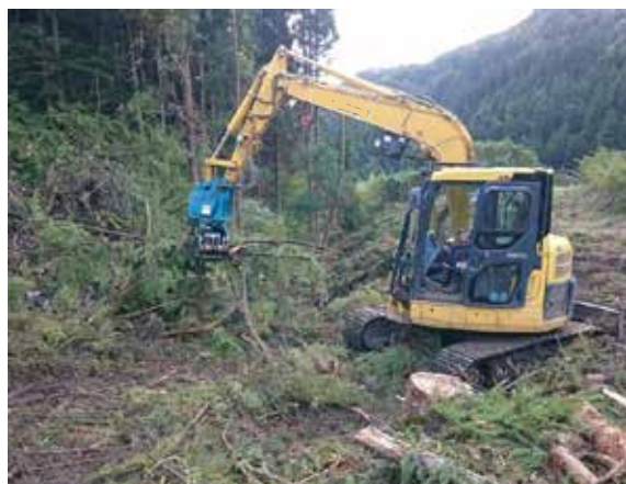
写真27 機械地拵えの様子
