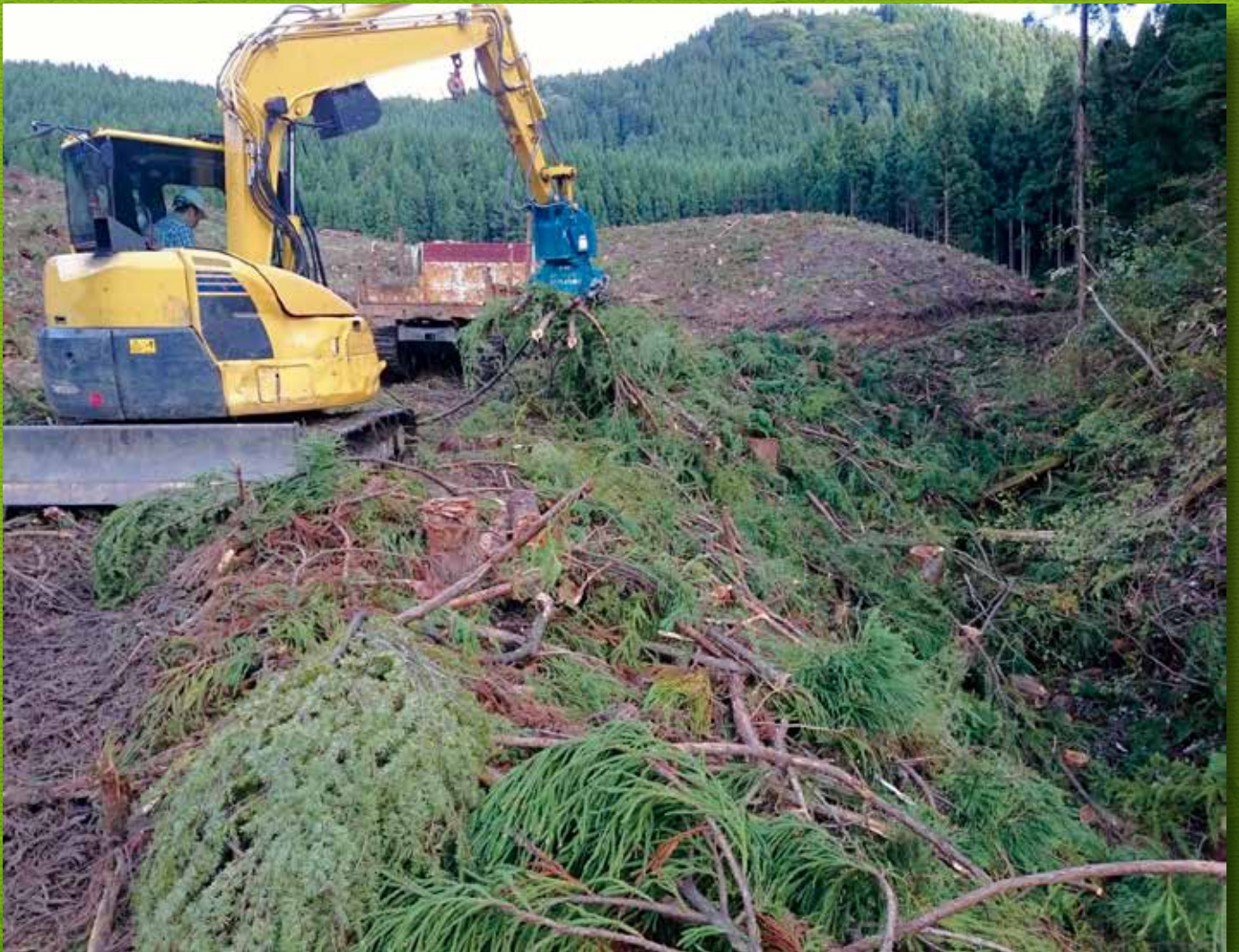
伐採・植栽一貫作業における機械地拵えの様子
