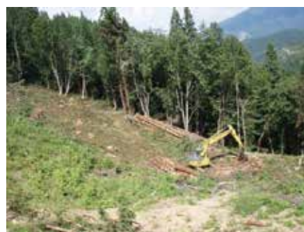
写真26 伐木・造材用林業機械を使った地拵え作業の効率化 (湯沢市小比内山国有林)
