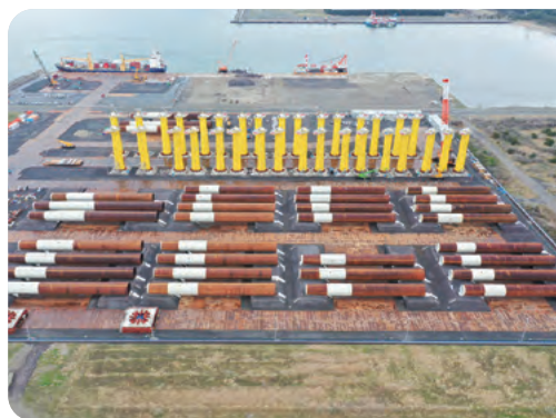
洋上風力の基礎部材（令和3年4月撮影） ©2021 秋田洋上風力発電株式会社
