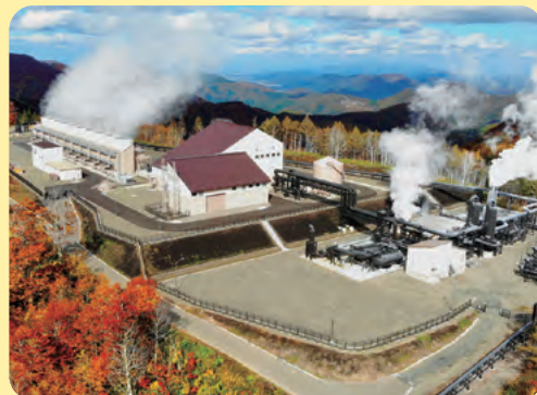
山葵沢地熱発電所 (写真提供: 湯沢地熱株式会社)
