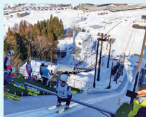
レーンにクーリングシステムが導入されたジャンプ台
