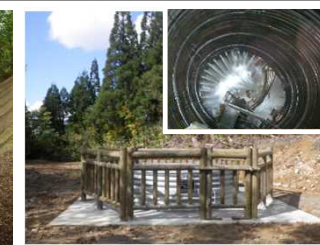
地すべり防止工
