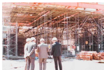
▲ 建設の槌音響く秋田県生涯教育センター
