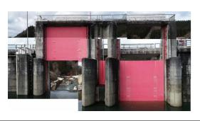
豪雨時に洪水調整を行い、農地・農業 ゲートの開閉により、放流量の調整を行 う。
