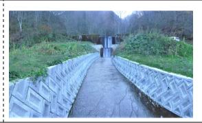
荒廃した渓流に小型ダムを設置し、土・流路を固定して乱流を防止し、縦断勾 配を規制して縦横浸食を防止する。
