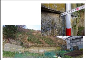
コンクリート土留工にひび割れや変状 が生じている。
