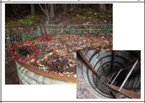
集水井工の天蓋や階段の腐食が生じて いる。
