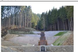
石流等の土砂流出を制御する。
