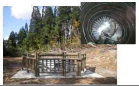
地下水が集中する場所に井戸を掘り、ボー リングで集水して、安定した場所へ排水する。
