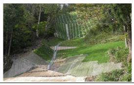
崩壊した山の斜面の浸食や拡大崩壊を 防ぎ、植生を回復させる。
