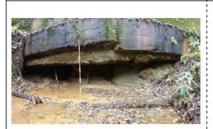
コンクリート治山ダム工の基礎洗掘が : 流路工のひび割れが生じている。 生じている。
