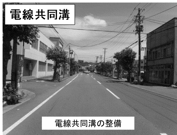
(主) 大館停車場線 御成町工区（大館市）
