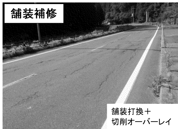
国道107号 大沢工区（横手市）
