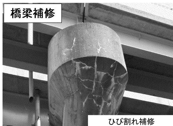
国道108号 鮎川橋（由利本荘市）
