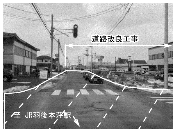
停車場栄町線 裏尾崎町（由利本荘市） 【道路改良工、支障物移設補償】
