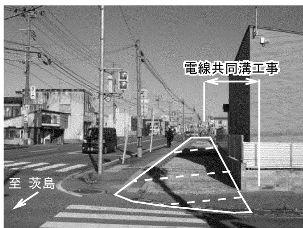
新屋土崎線 旭南（秋田市） 【電線共同溝工、支障物移設補償】
