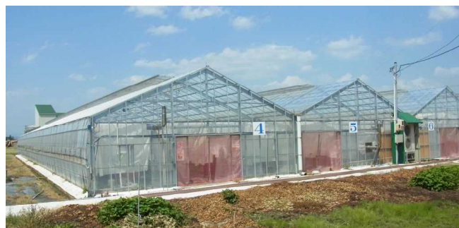
【増棟した鉄骨連棟ハウス】
