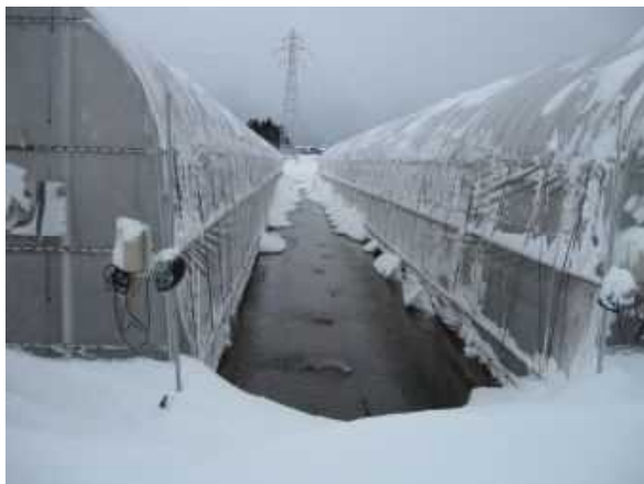
【プール構造による積雪対策】
