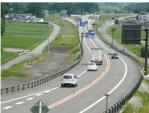
▲ 国道 46 号 角館バイパス(整備済み)
