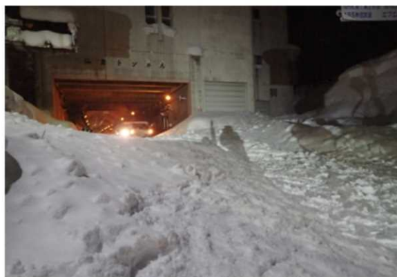
(H30.2 雪崩被災状況)
