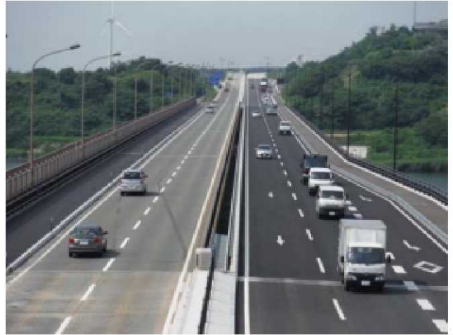
▲4車線化された秋田南バイパス
