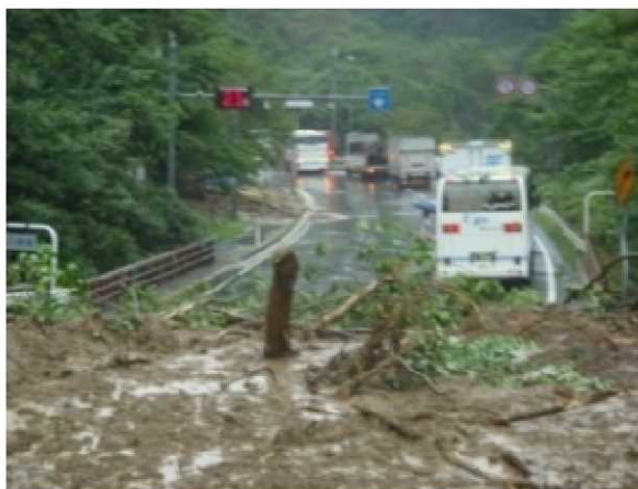
▲国道46号における崩土発生後の状況(H25.8.9)
