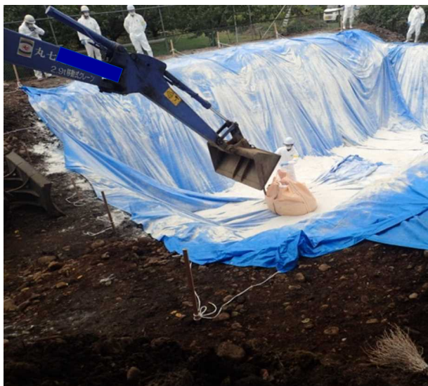
〔埋却溝の試掘及び埋却作業〕
