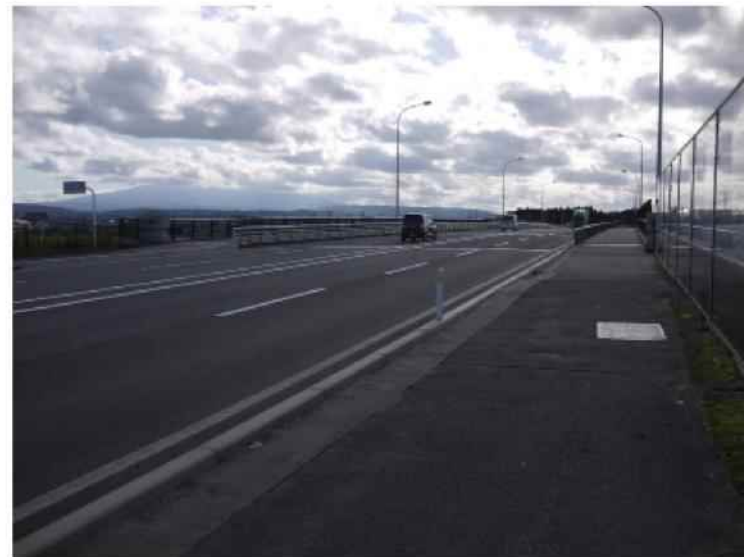
現在の橋の様子
