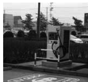
急速充電器（県庁第二庁舎）
