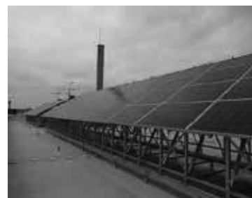
県庁舎屋上に設置した 太陽光発電設備
