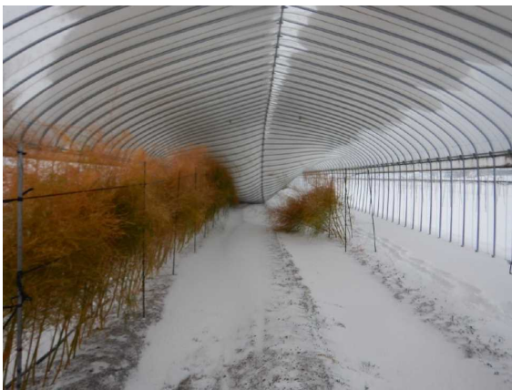
[農業生産用施設 (アスパラガス、由利本荘市)]
