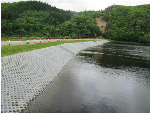
ため池の改修
