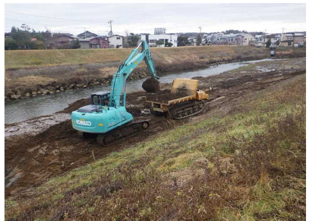
河川の土砂掘削
