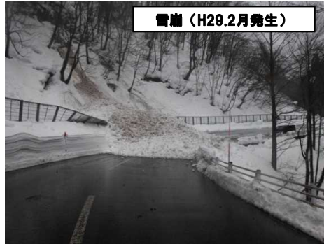
国道105号「大覚野峠地区」の現道において 雪崩による通行規制が発生
