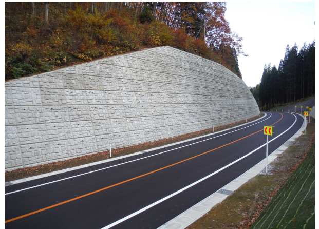
道路の法面对策
