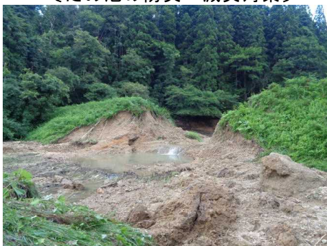
令和2年7月豪雨によるため池の決壊 下が沢上ため池（秋田市）
