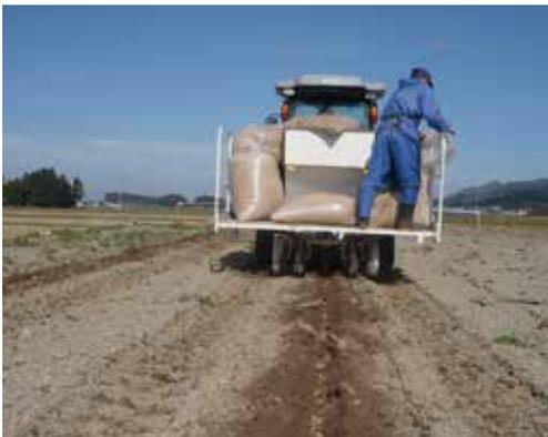
モミガラ補助暗渠の施工状況（湯沢市）
