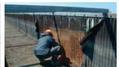
腐食が進む幹線用水路
