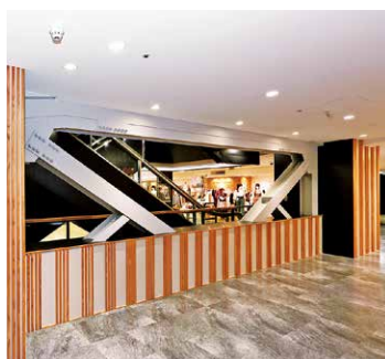
■ 2階エスカレーター横 （耐震補強周り柱・腰壁スギ化粧貼り）
