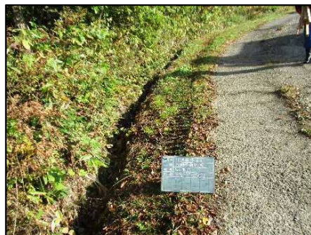
【施工前の水路状況】
