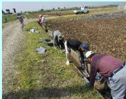
水路の補修作業
