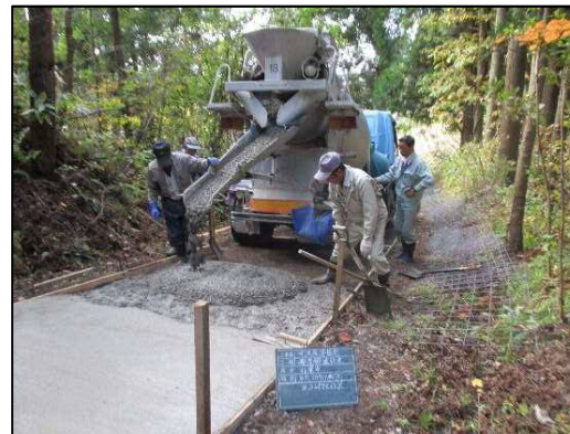
【農道の舗装作業】
