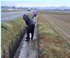
水路の泥上げ作業
