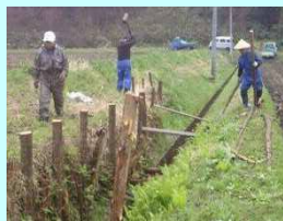
水路の補修作業
