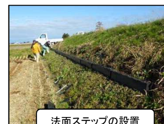
法面ステップの設置
