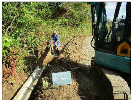
【水路の更新作業】
