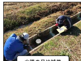
水路の目地補修
