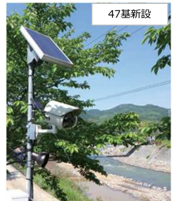
図 河川監視カメラの例
