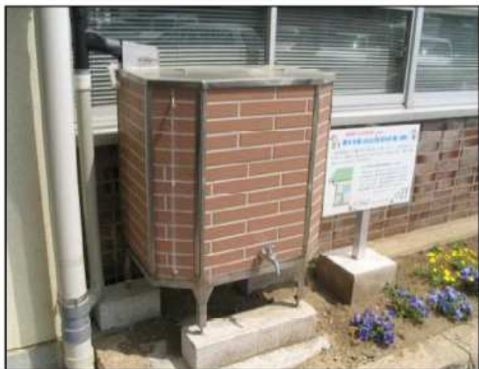
雨水貯留槽の設置例
