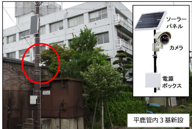
図3 河川監視カメラ(横手川・上の橋)
