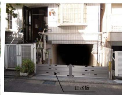
浸水被害の軽減と雨水の有効利用（参考：日立市）
