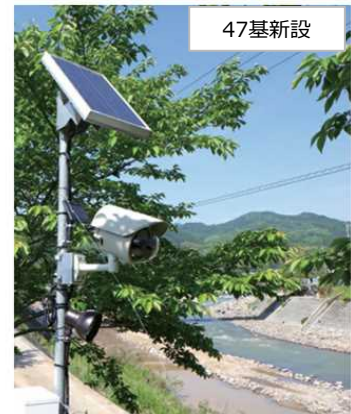
図 河川監視カメラの例
