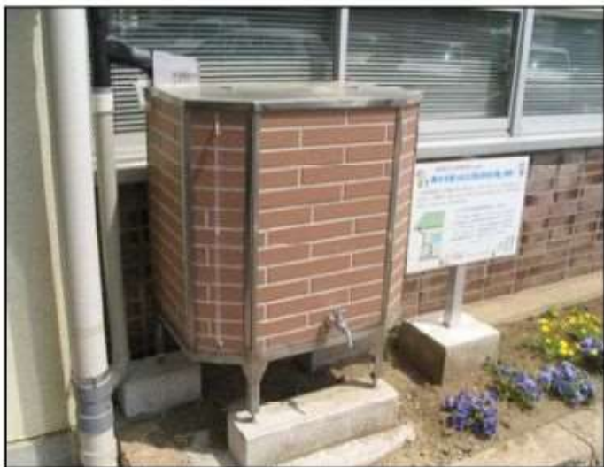
雨水貯留槽の設置例
