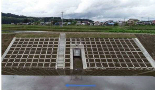
小阿仁川 三木田工区(12号排水樋管完成)
