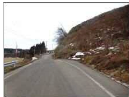
◆矢坂糠沢線の狭隘部
