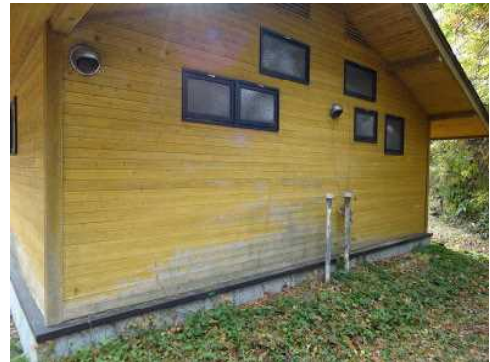
↑ 塗装の剥げが見られる外壁
