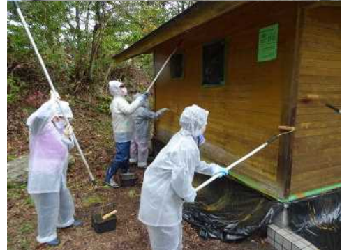
↑ 塗装作業の様子
