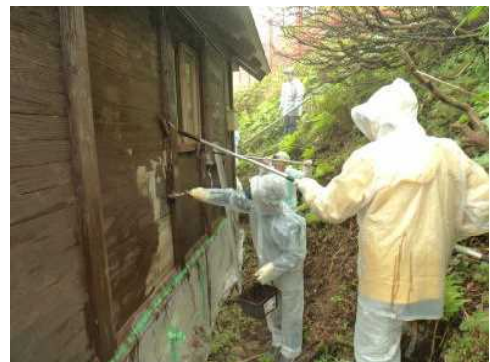
↑塗装作業の様子
