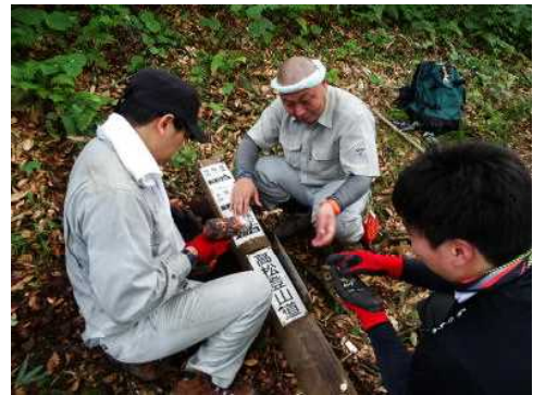
↑標柱の交換作業 新しい標柱に盤面を取り付け
