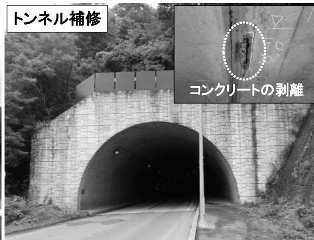
国道107号 黄桜トンネル （由利本荘市）
