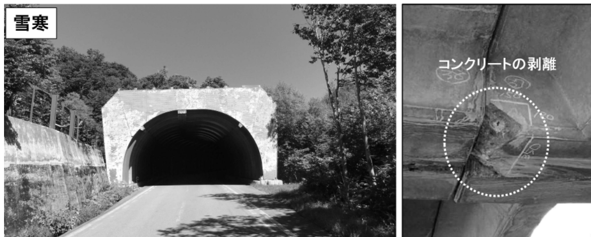
国道341号 玉川4号スノーシェルター（仙北市）
