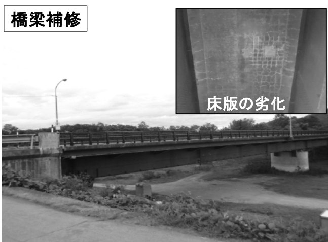
国道105号 大曲大橋 （大仙市）
